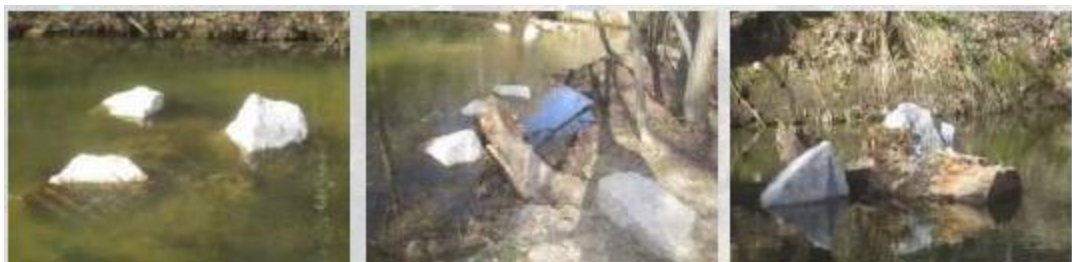
Figura 1. Estructuras para la diversificación del hábitat fluvial. La imagen de la izquierda corresponde a una unidad de centro; las imágenes del centro y la derecha corresponden a una unidad e orilla.
