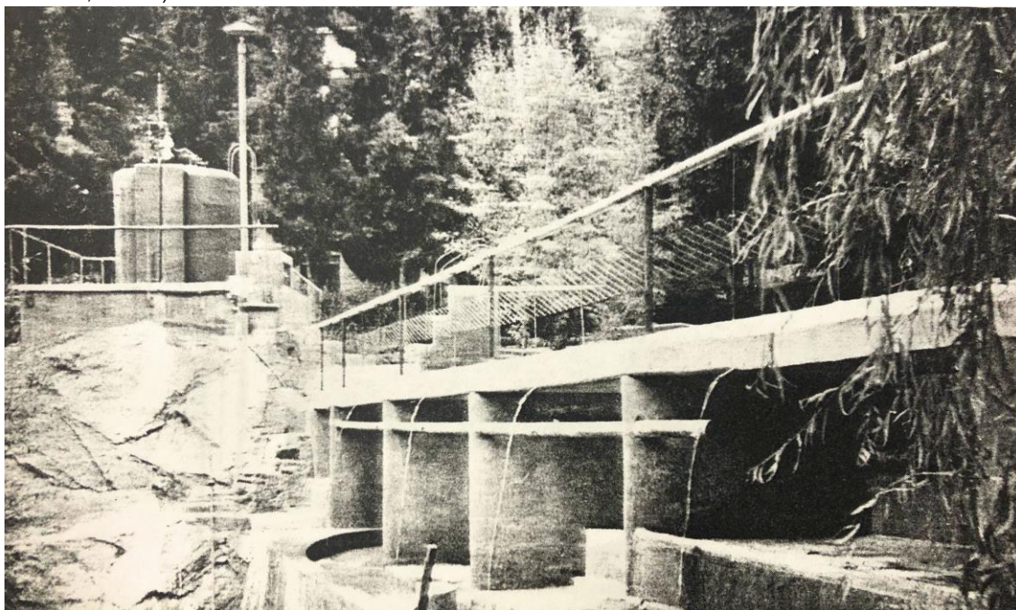
Figura 4. Dique número 6 del Barranco del Salado, adaptado para aforo por el método de disoluciones comparadas. (GARCÍA NÁJERA, 1956).
