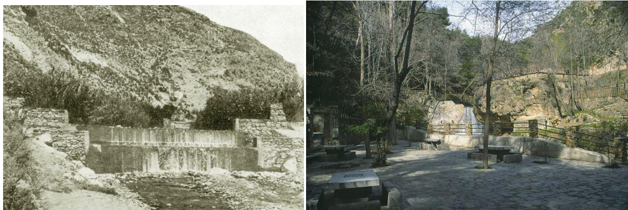
Figuras 22 y 23. Restauración Obras de corrección hidrológico - forestal en El Nacimiento de la cuenca alta del río Andarax 1943 aproximado y 2001. Fuente Fototeca Forestal INIA.
