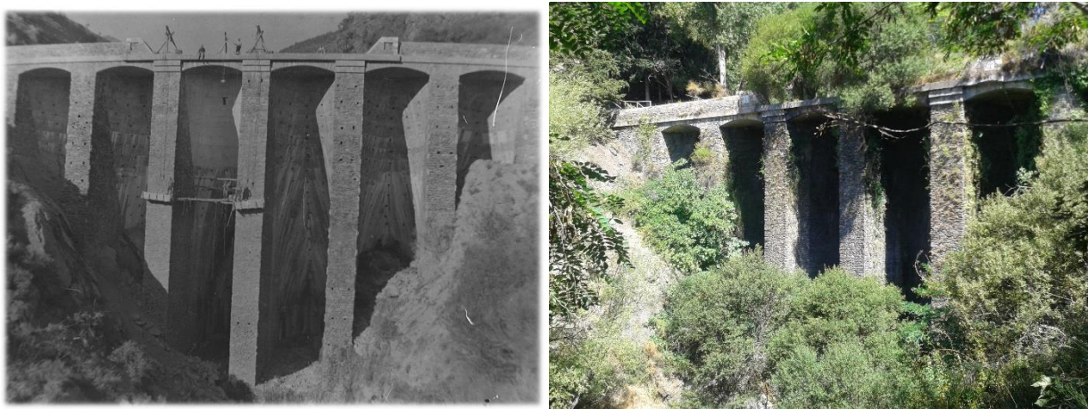
Figuras 13 a y b. Izquierda (a) vista cercana del dique 1-B de 29,30 metros de altura y 67 de coronación, en el río Chico, a su finalización año 1943. Derecha (13b) en el año 2.015. Fuente: Fototeca INIA y Autor, trabajos de campo 2 015.
