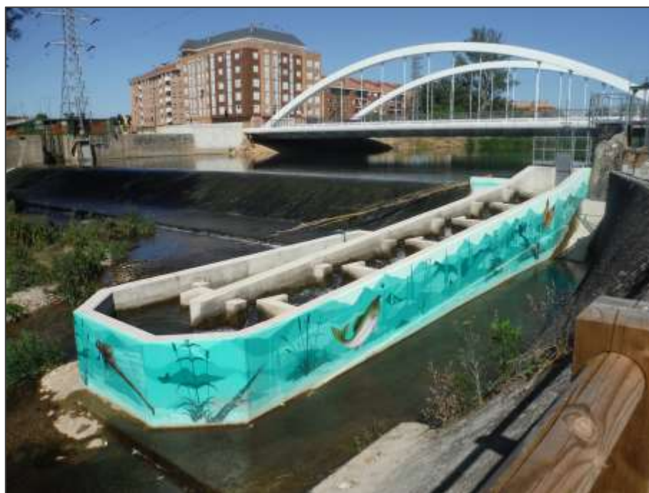
Figura 3. Ejemplo de escala para peces de hendidura vertical con un estanque de cambio de dirección de 180° con esquinas achaflanadas, situada en el río Arlanzón en ciudad de Burgos (Misma escala que la de la figura 2).
